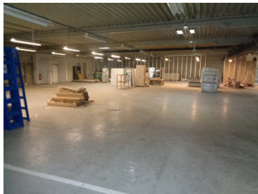
Figure 16 : Intérieur du dépôt en travaux
