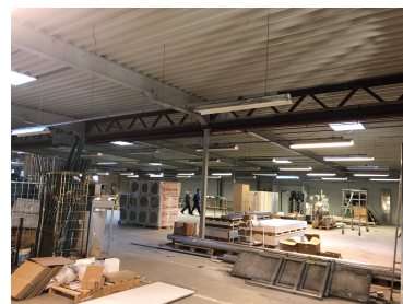
Figure 17 : Intérieur du dépôt en travaux
