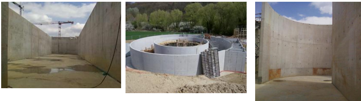
Fig. 2: Vues de bassins de stations d'épuration en béton armé
